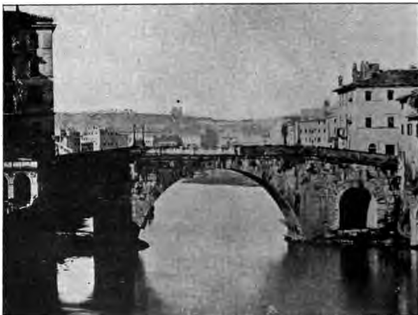
FIG. 16. — LE PONT DE GRATIEN
